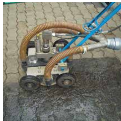
(手前)施工前 (奥)施工後
