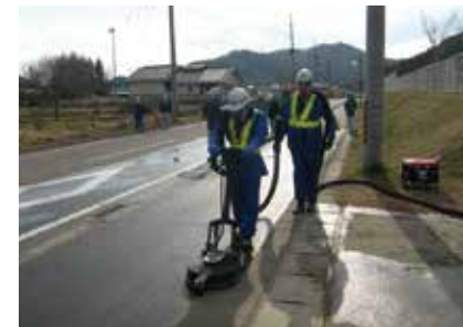
施工現場全景
