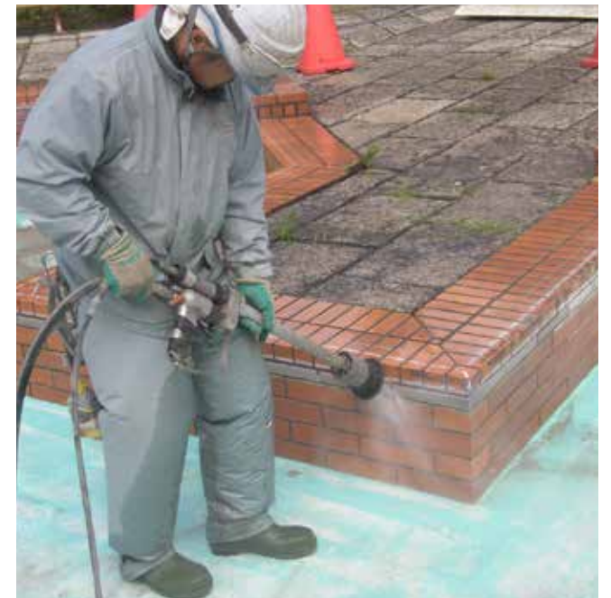
防水層塗装前の目荒らし処理
