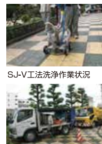
SJ-V工法洗浄作業状況 洗浄機材
