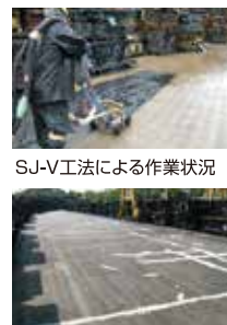
SJ-V工法による作業状況 作業完了状況
