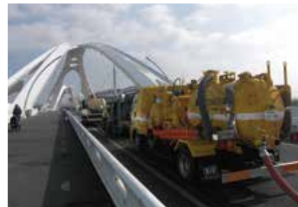
現場全景・機材配置
