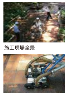
施工現場全景 スピンジェット(洗浄機材)
