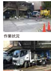
作業状況 超高压洗浄車
