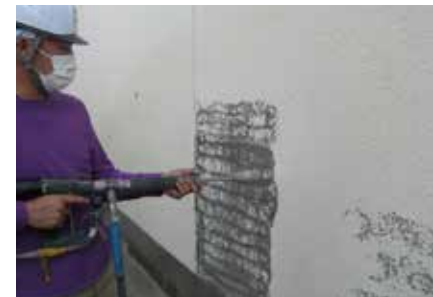
回転ガン作業状況
