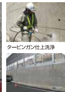
タービンガン仕上洗浄 作業完了状況
