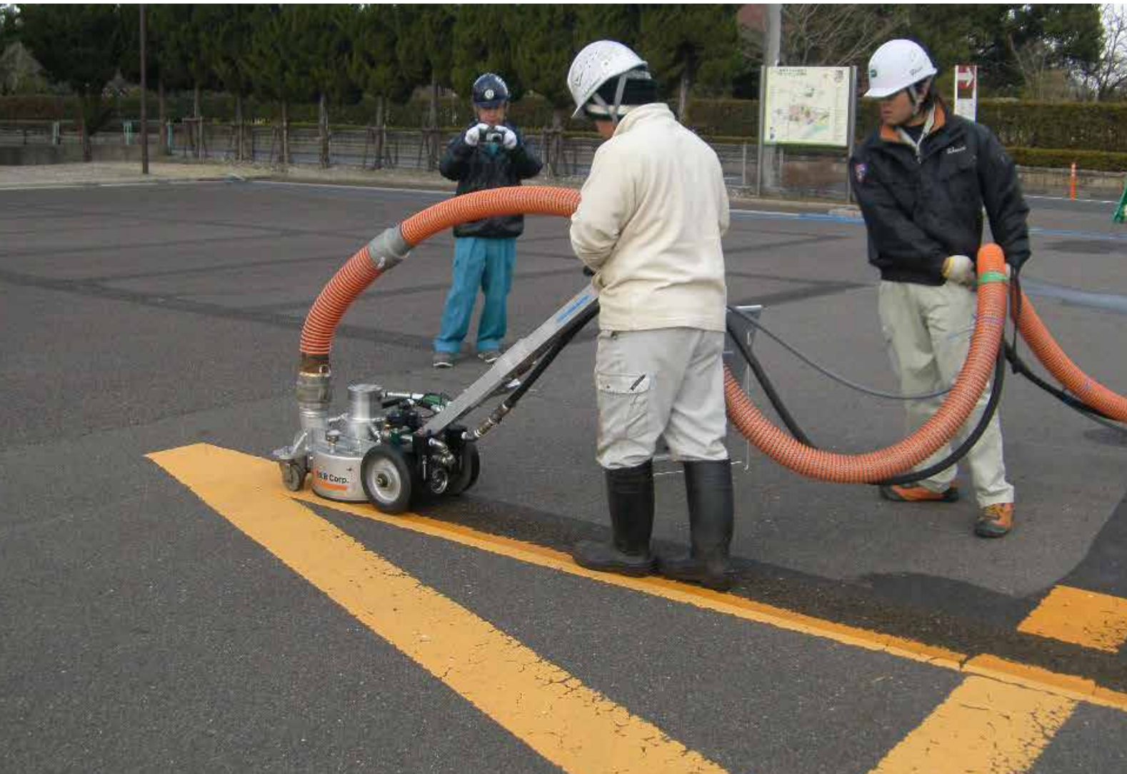
パワフルな超高压水噴射で道路や駐車場などの標示塗膜～区画線も簡単に剥離除去可能。
