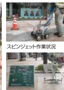
スピンジェット作業状況 滑り抵抗値(BPN)試験
