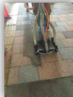
超高圧 (150MPa) 洗浄<同時吸引式>
