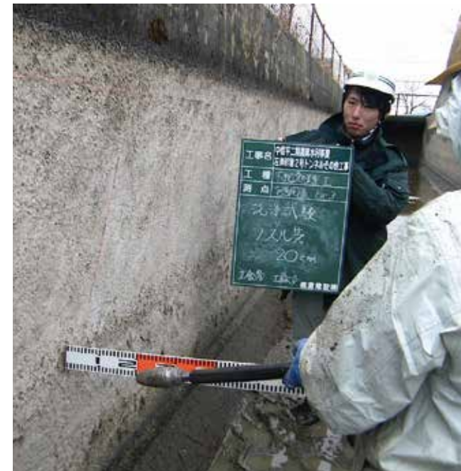
コンクリート表面の目荒らし処理
