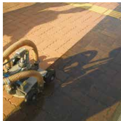
(右)施工前 (左)施工後
