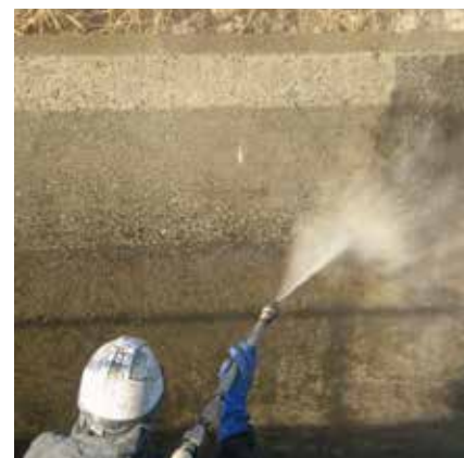
(上)施工後 (下)施工前(水路洗浄)
