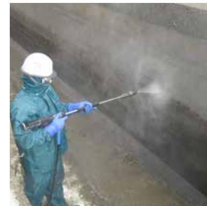
コンクリート表面処理
