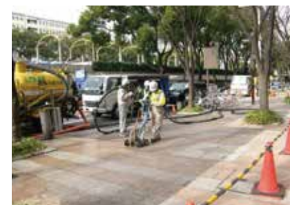
施工現場全景
