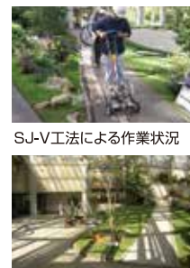
SJ-V工法による作業状況 温室以内での作業状況
