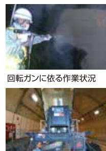
回転ガンに依る作業状況 洗浄機材
