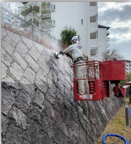
壁面洗浄作業状況
