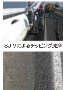
SJ-Vによるチップング洗浄 チップング洗浄前／洗浄完了
