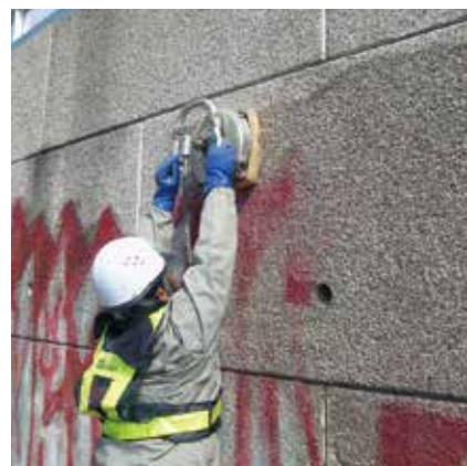
(手前)施工後 (奥)施工前(落書き除去)
