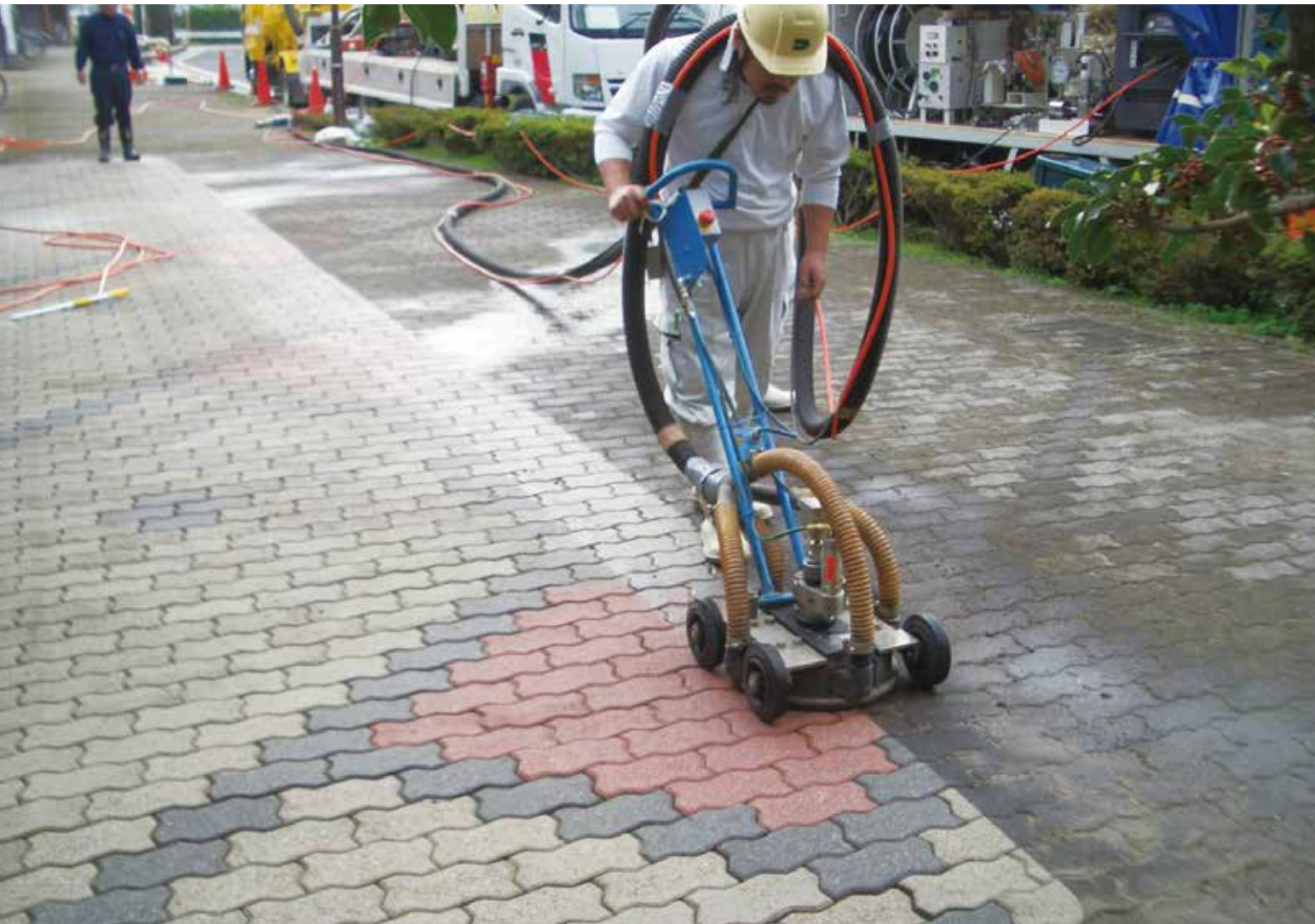
造る時代から管理する時代へ。竣工当時の美しく安全な舗装を回復します。
