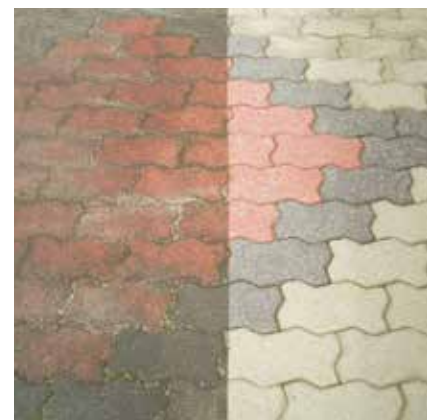
(左)施工前 (右)施工後
