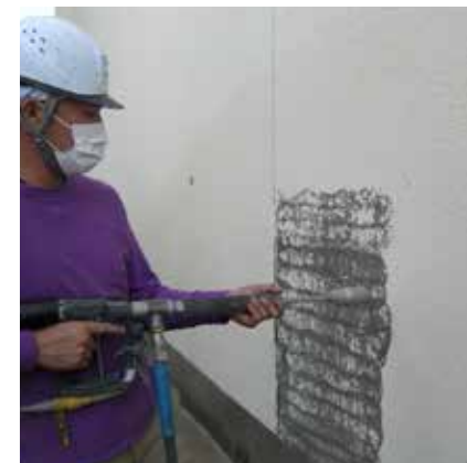
塗装の前処理・塗膜除去
