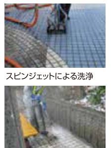
スピンジェットによる洗浄 端部ハンドガンによる洗浄
