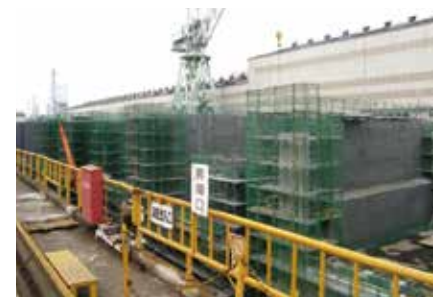
施工現場全景
