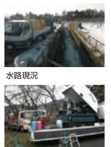
水路現況 高圧洗浄機材
