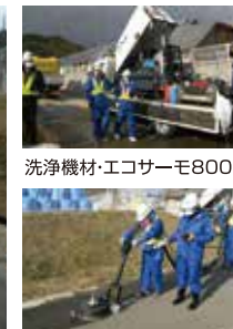
洗浄機材・エコサーモ800 作業状況
