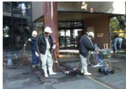
SJ-V工法による作業状況
