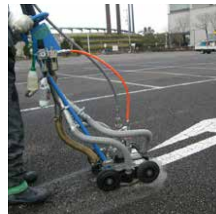
(手前)施工前 (奥)施工後(区画線消去)
