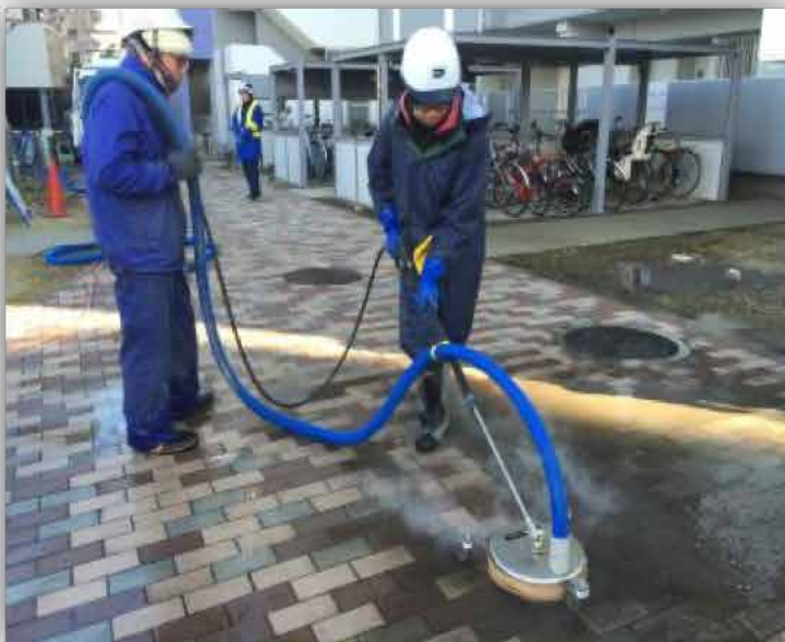
(ILB舗装洗浄作業状況)
