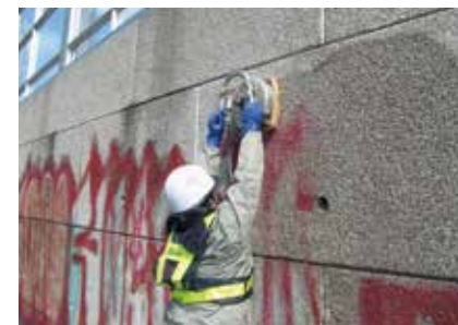
吸引式洗浄ユニット作業
