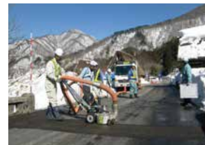
施工現場全景
