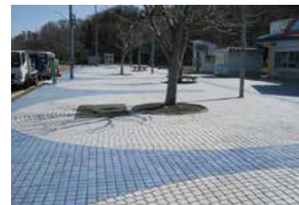
SJ-V工法による洗浄後全景
