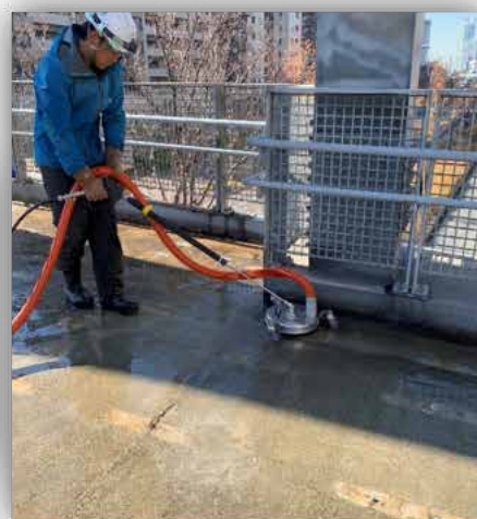
床用 (オールウィフ-300) 作業状況
