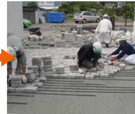
ガイドレール敷設
