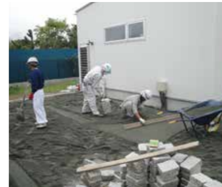
敷砂転圧・高さ調整
